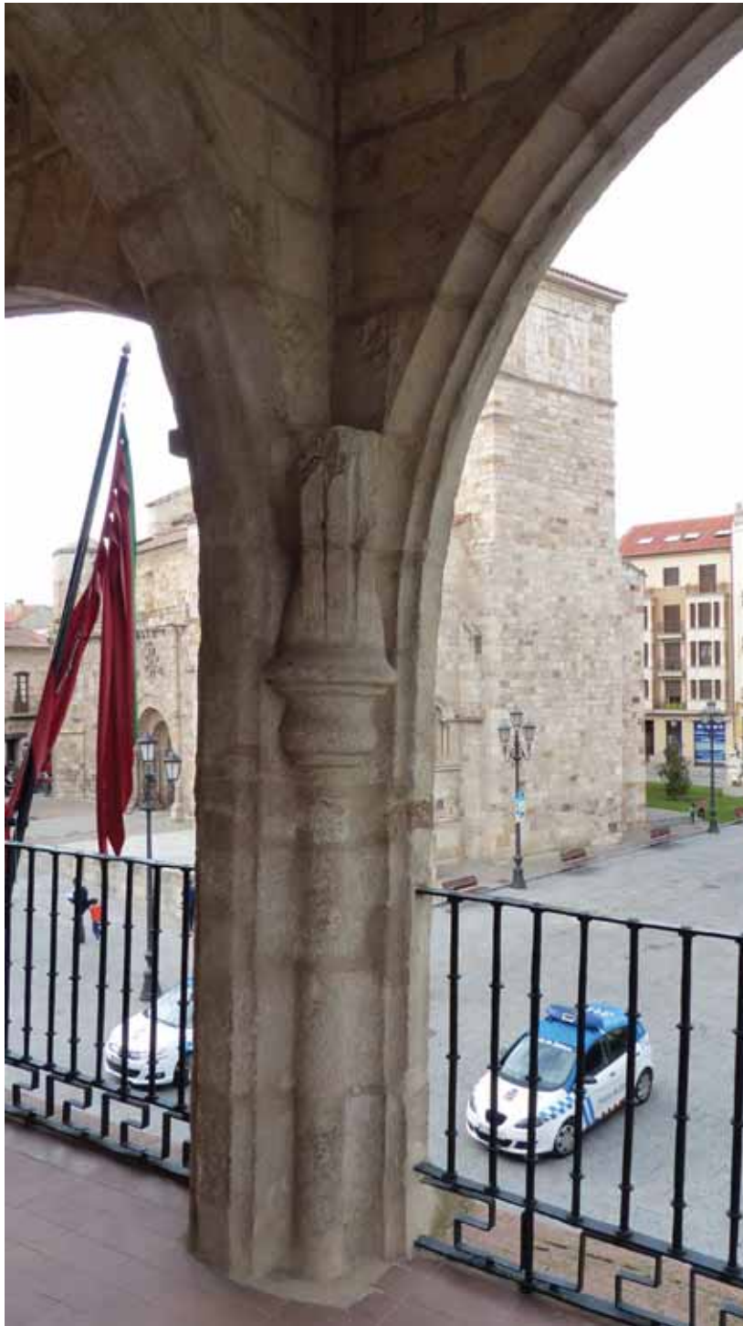
Figura 3. El Ayuntamiento viejo. Arranque de la desaparecida bóveda de crucería de la torrecilla oriental de la fachada.
