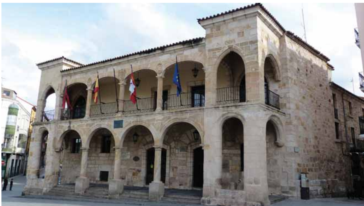
Figura 2. El Ayuntamiento viejo. Fachada principal.
